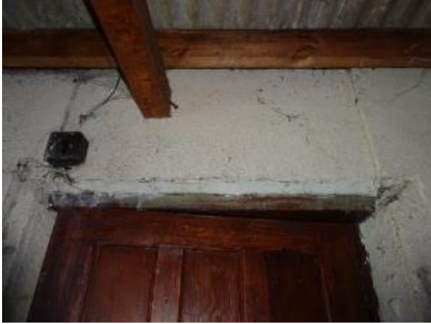
17 - Timber lintel above side door
